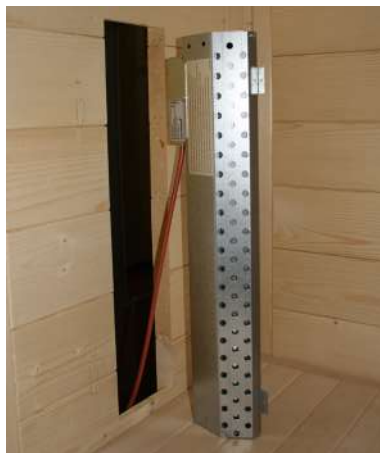
Fig. 2: Posição da caixa de ligação
