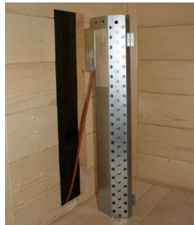
Abb. 2: Position Anschlusskasten
