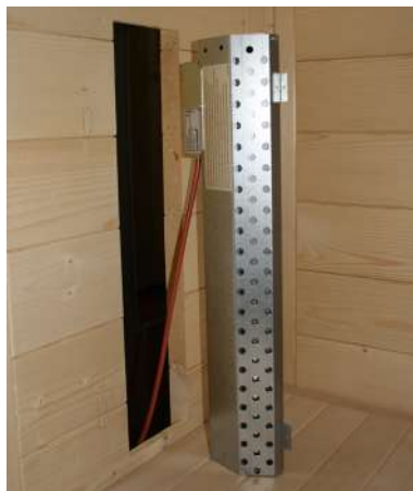
rys. 2: Pozycja skrzynki przyłączowej
