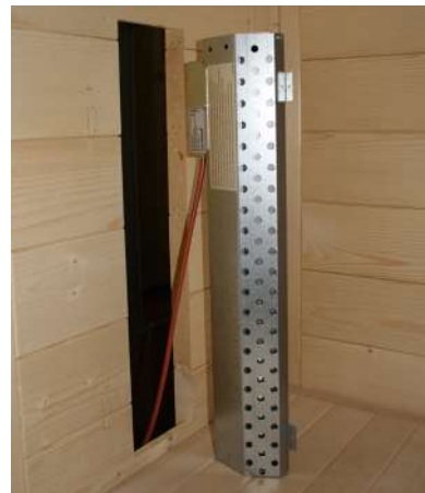
Fig. 2: Posizione morsettiera
